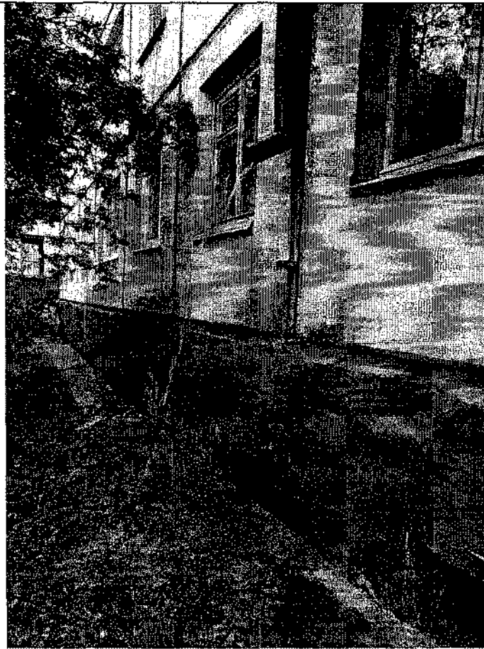
Фото 5. Отмостка и стены. Наличие трещин и отхождение отмостки от стен здания. Следы замачивания стен
